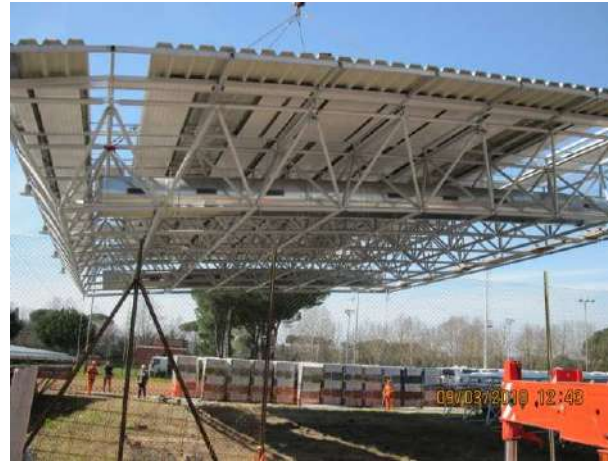
Montaggio della copertura
